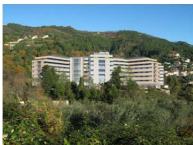
25. Il “nuovo” Felettino in corso di realizzazione a La Spezia
