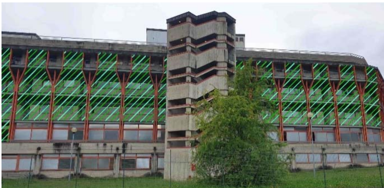
22. Il "verde verticale" sulla facciata del San Bartolomeo!
